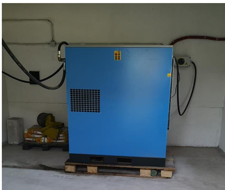
Obr. 7. Šroubový tryskací kompresor pro otryskávání povrchu povlakované oceli
