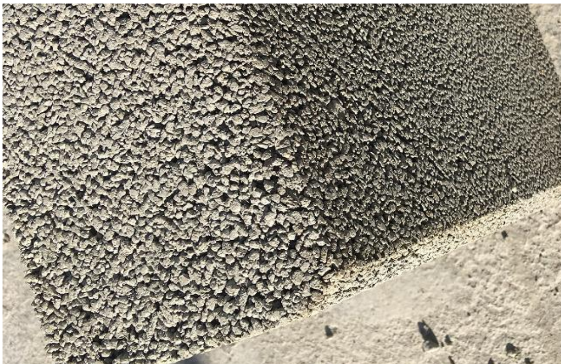
Obr. 16. Vizualizace mezerovitého betonu části vytvořené protihlukové stěny nové generace - detail
