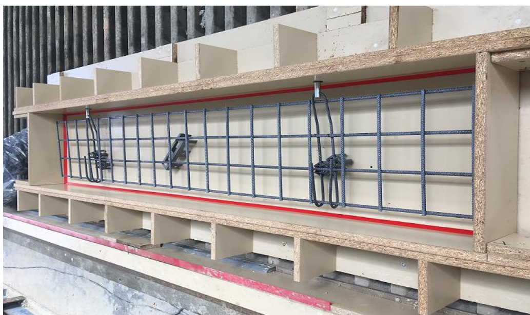
Obr. 13. Realizace bednění s uložením výztuže (kari sítě) pro tvorbu protihlukové stěny nové generace
