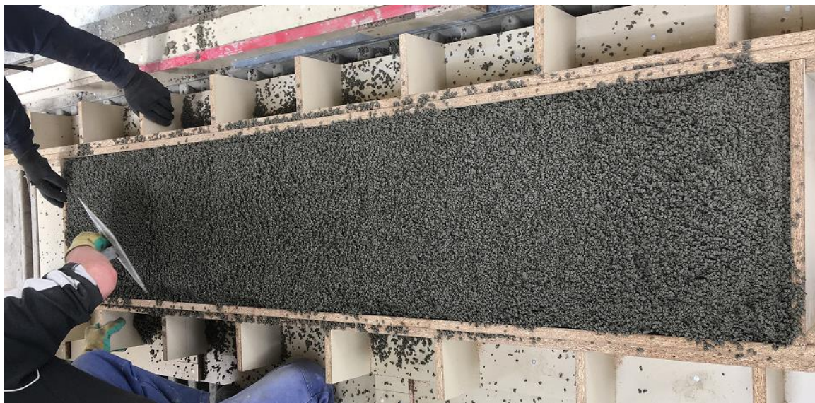
Obr. 14. Aplikace tuhnoucího mezerovitého betonu do bednění (realizace protihlukové stěny nové generace)
