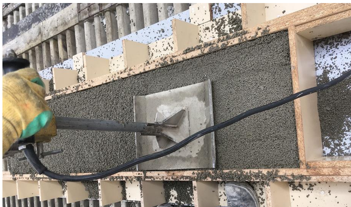
Obr. 15. Tyčové vibrační zařízení pro hutnění mezerovitého betonu
